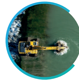
Lancement des travaux
