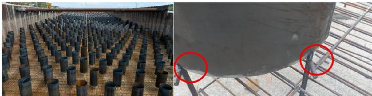
L'étape suivante a consisté à couler les couches supérieures de béton (épaisseur : 50 cm) qui recouvrent toute la hauteur du ferrailage et la base des plots. Par la suite, pour casser les vitesses du courant dans le fond des passes-à-poissons les ouvriers ont mis en place manuellement des rugosités de fond.
