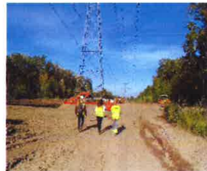
Figure 2. Travaux d'enfouissement de Cannes de Provence sous la ligne RTE
