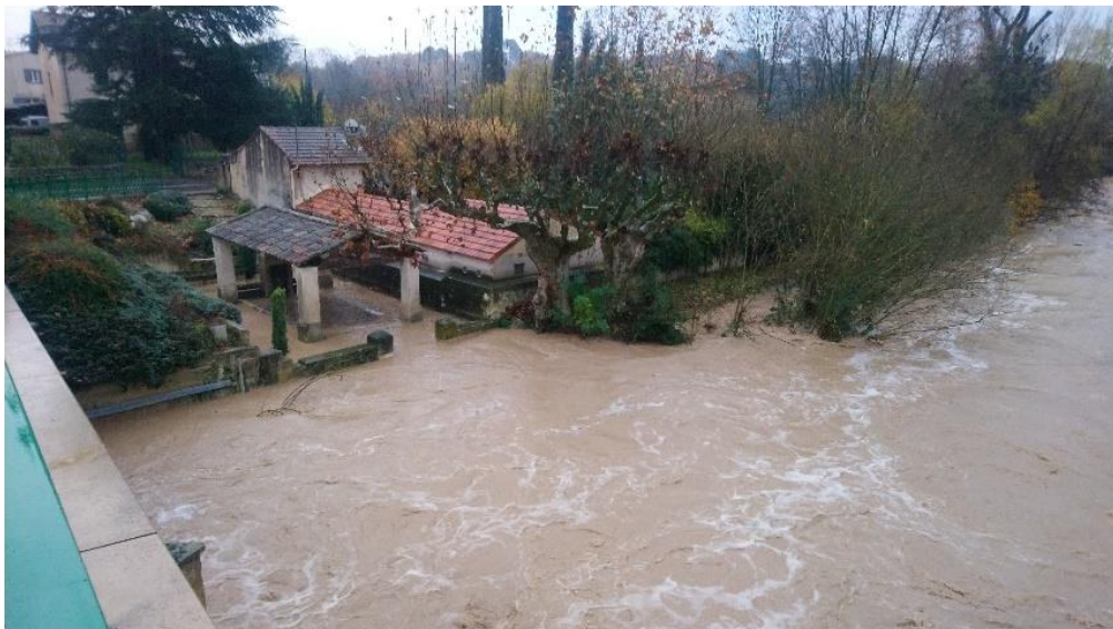
Photo : Eze en crue à la Tour d'Aigues (nov. 2019)
