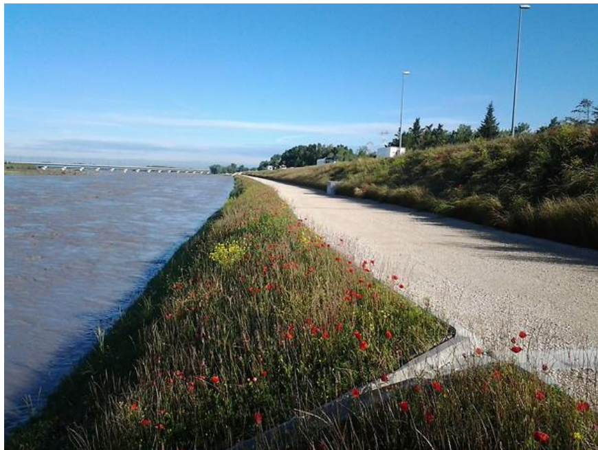
Photo : dique Saint Jacques à Cavaillon
